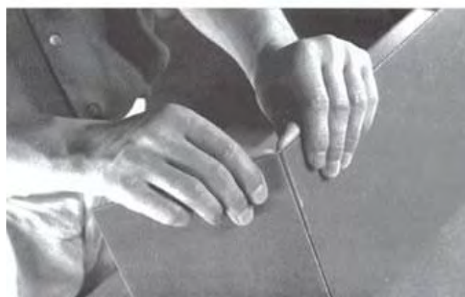
Рисунок 11 - Нанесение бороздки и поломка
