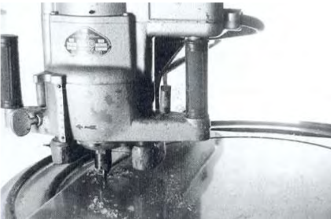
Рисунок 18 - Торцевая фреза
